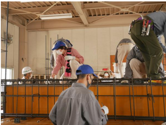
実際に鉄筋を組み、型枠を作っている様子
